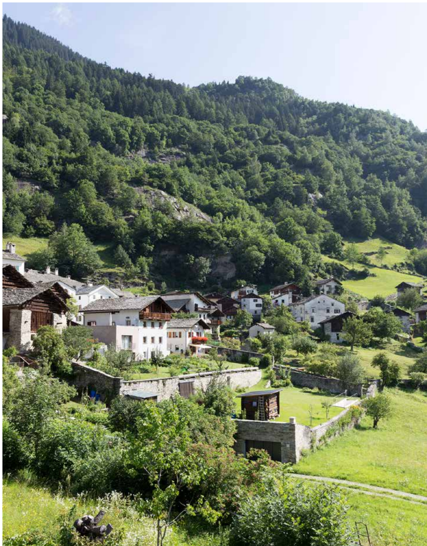
Soglio GR: Mit grosser Sorgfalt wurde eine Tiefgarage in die geschützte «Nutz- und Ziergartenzone» untergebracht. Die originalen Trockenmauern und die nicht asphaltierte Zufahrtsstrasse reduzierten die sichtbare Einwirkung auf das Ortsbild.
