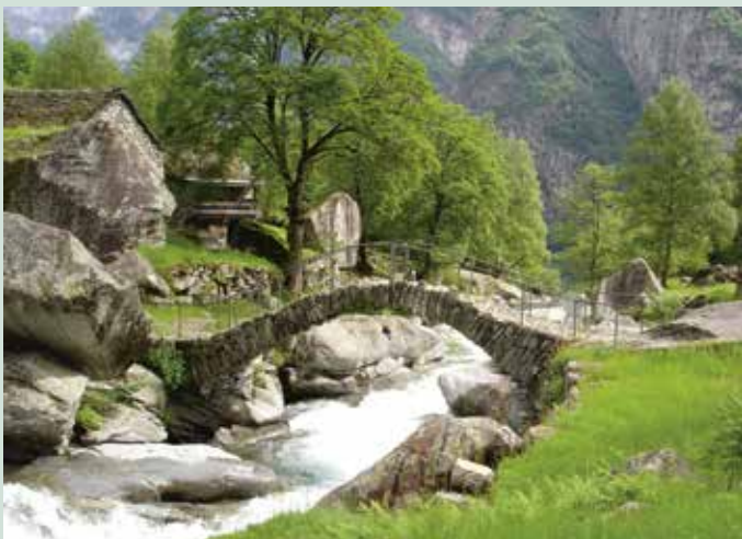
Steinbogenbrücke von Puntid im Bavonatal TI
