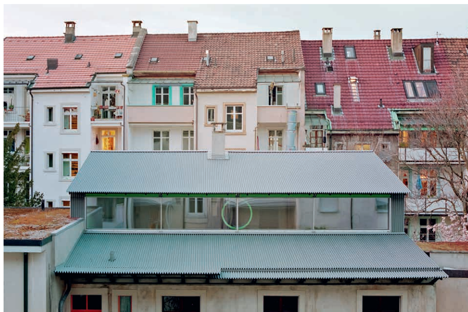
Renovation/Umbau «Haus im Hof», Matthäusstrasse 7, Basel
