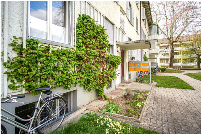
10 Die Bauten der Meienegg sind überdurchschnittlich gut erhalten: Neben den Eingängen mit ihren geschwungenen Vordächern sind auch die handbearbeiteten Putzflächen und die bauzeitlichen Wandspalier erhalten.
