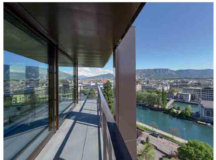
Stahlstütze, die ebenso wie die Betonstützen der unteren Geschosse mit Metall verkleidet ist, und transparente Brüstung im neuen Attikageschoss La colonne d'acier capotée de métal comme les piliers de béton des étages inférieurs et les garde-corps transparents du nouvel attique.
