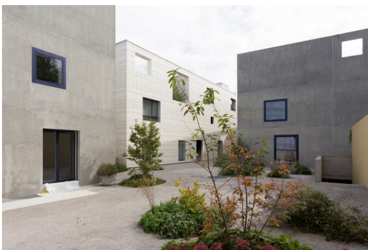
Bild 6: Überbauung Mergenthaler (© James Batten/Schweizer Heimatschutz)
