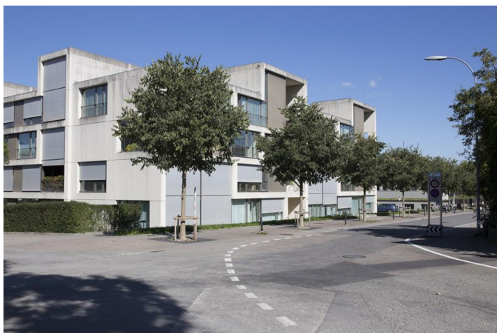
Photo 3: Le complexe d'habitation Pile up (© James Batten/Patrimoine suisse)
