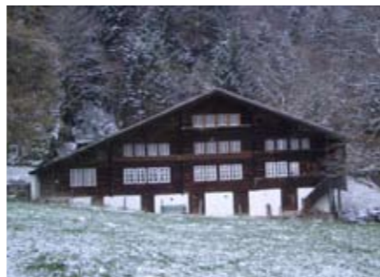
Photos : Maison d'habitation traditionnelle en grumes pièce sur pièce et bâtiment rural.
